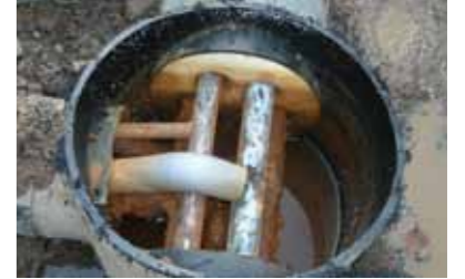
Silmämääräinen tarkastus (ulkopuolisen kanaalin risteys avattuna).
